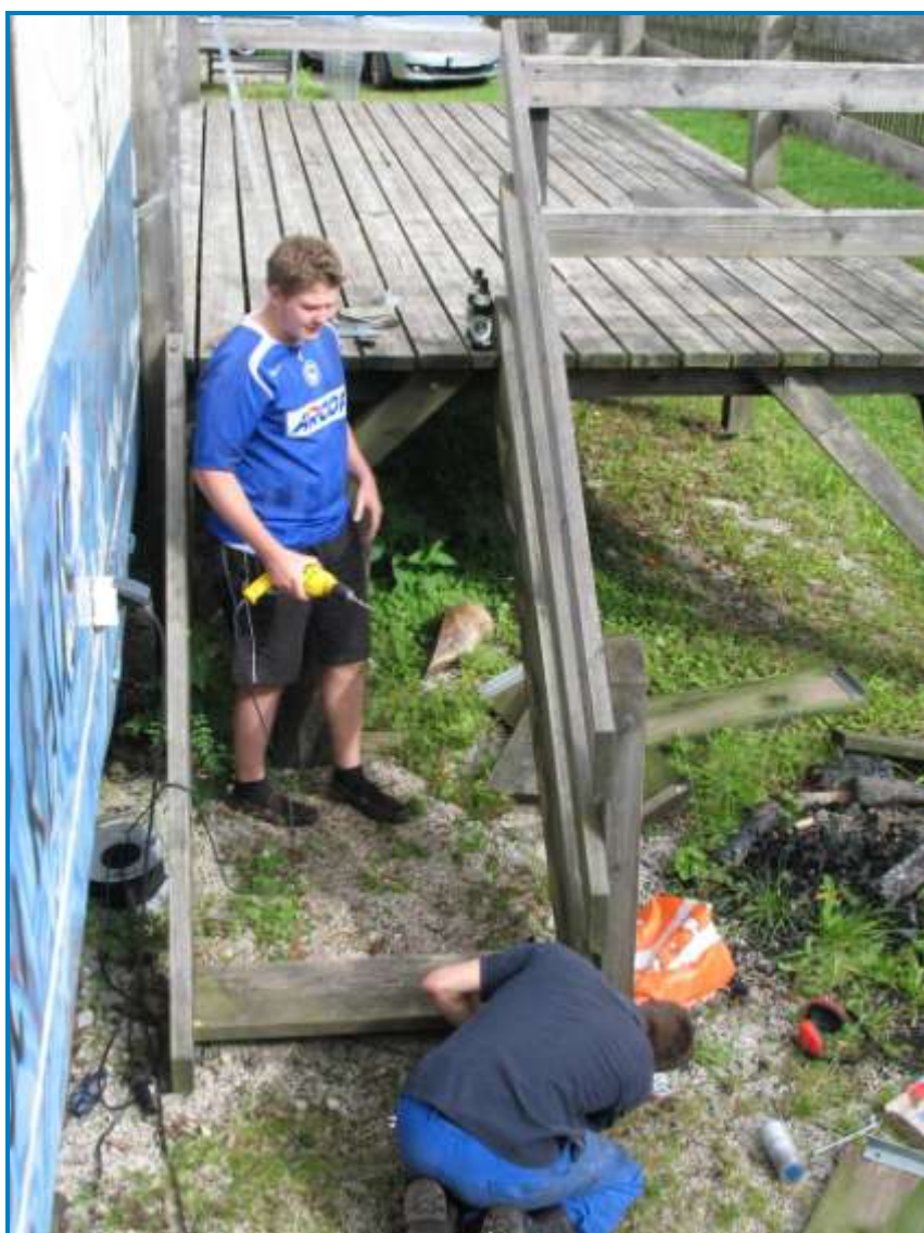
Reparatur der Treppe am Balkon durch 2 unserer Jugendleiter
